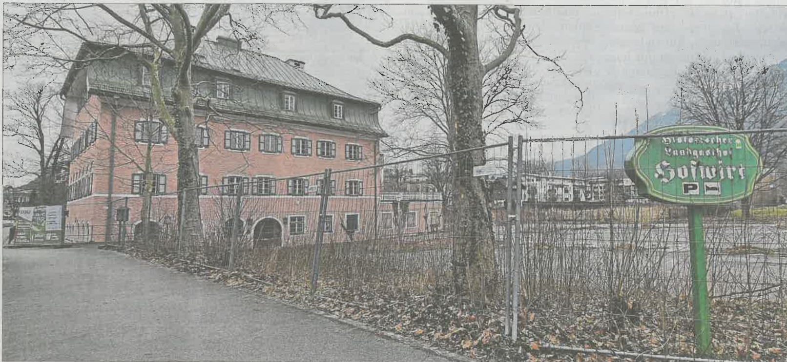
Seit mehr als zehn Jahren steht der Hofwirt leer. Er soll saniert werden, auf der Fläche dahinter soll ein Hotel entstehen.
