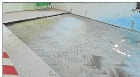
Das Salettl befindet sich allgemein in einem guten Zustand, vor allem der Parkettboden ist gut erhalten.
