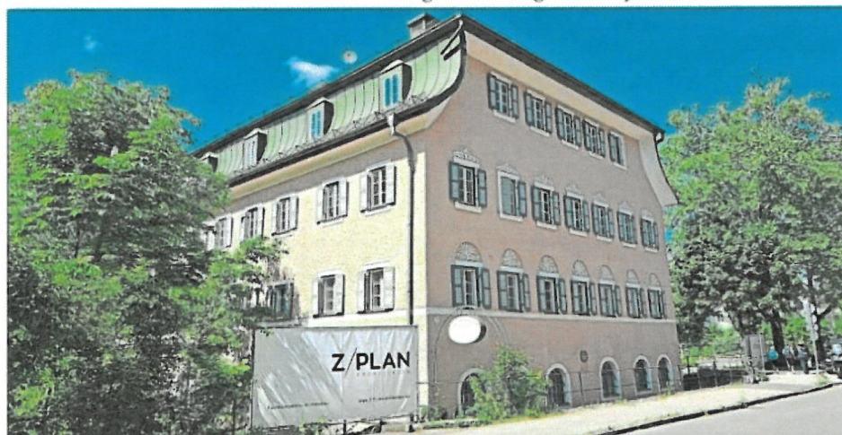
Der Hofwirt ist denkmalgeschützt und soll saniert werden. Im Inneren sind kleine Konferenzzimmer geplant, in den oberen Etagen sollen Mitarbeiter untergebracht werden.
